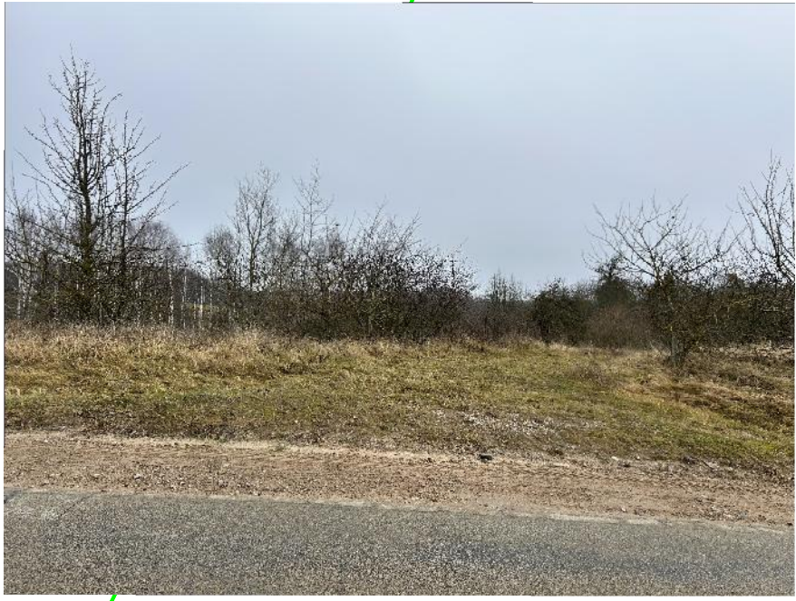
Nuovaža | laukus (4p) PK 40+88 Nuovaža suvedama su esamam paviršumam. Nuovaža | laukus - registruota statinio kadaistro byloje. Projektuojama 4p tipo nuovaža su asfaltbetonio dangia.
